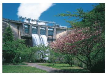
大倉ふるさとセンターからすぐ近くにある大倉ダムは、1962年に日本で最初に完成した"ダブルアーチ 式コンクリートダム"である。ダム本体は、中央にスラストブロック(巨大なコンクリート塊)を設置した2連の アーチ形状となっており、国内では非常に珍しいダム。春は桜、秋は紅葉が湖面に映り、美しい景観をつくる。 交 165P参照
